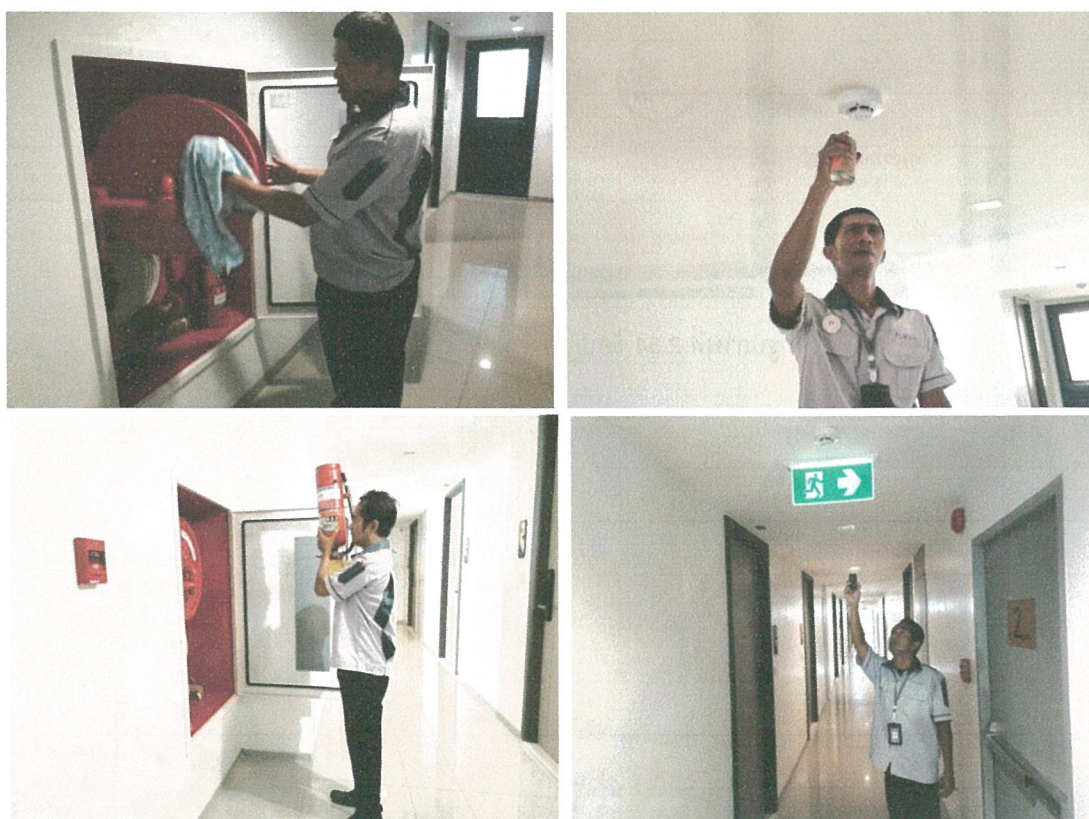
รูปภาพที่ 2.37 การตรวจสอบอุปกรณ์ป้องกันและแจ้งเตือนอัคคีภัย
