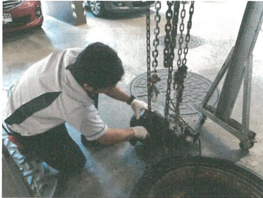
รูปภาพที่ 2.28 การตรวจเช็คระบบบำบัดน้ำเสีย
