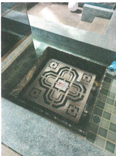
รูปภาพที่ 2.30 รางระบายน้ำต้นขอบสระว่ายน้ำ
